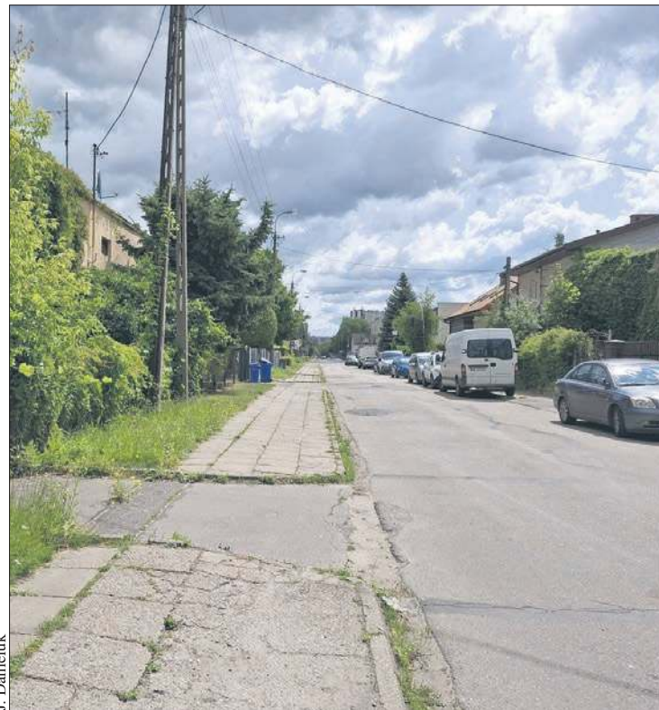
Część ulicy Lasockiego wymaga remontu
