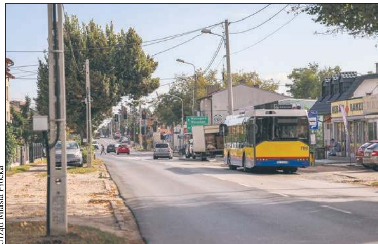
Czas na remont ulicy Wyszogrodzkiej
