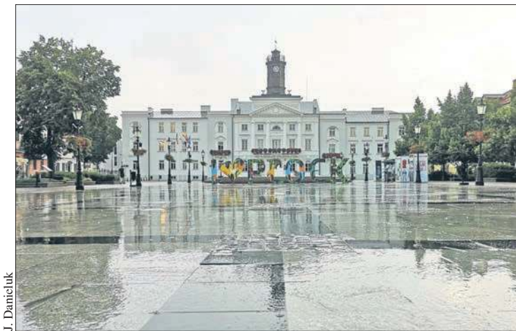
Budynek Urzędu Miasta w Płocku
