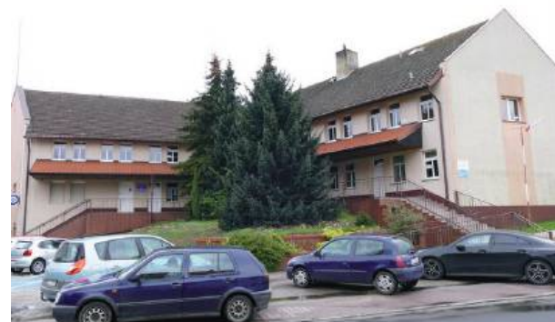
W połowie lutego została podpisana umowa na remont dachu Ośrodka Zdrowia w Przewornie
