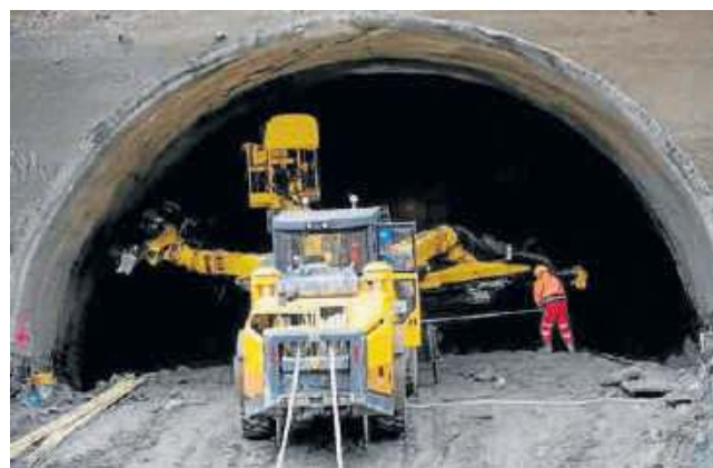
Pierwszy z tuneli pod Baranią Górą już dobrze widać. Jest drążony górniczą austriacką metodą
