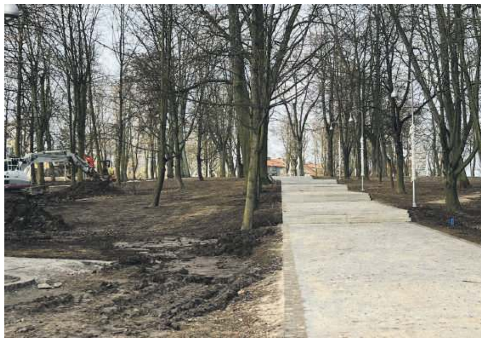
Na przebudowanych schodach brak podjazdów dla wózków. Mieszkańcy pytają, czy tak powinno być
