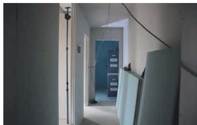
Jedno z remontowanych mieszkań w Piotrkowiczkach
