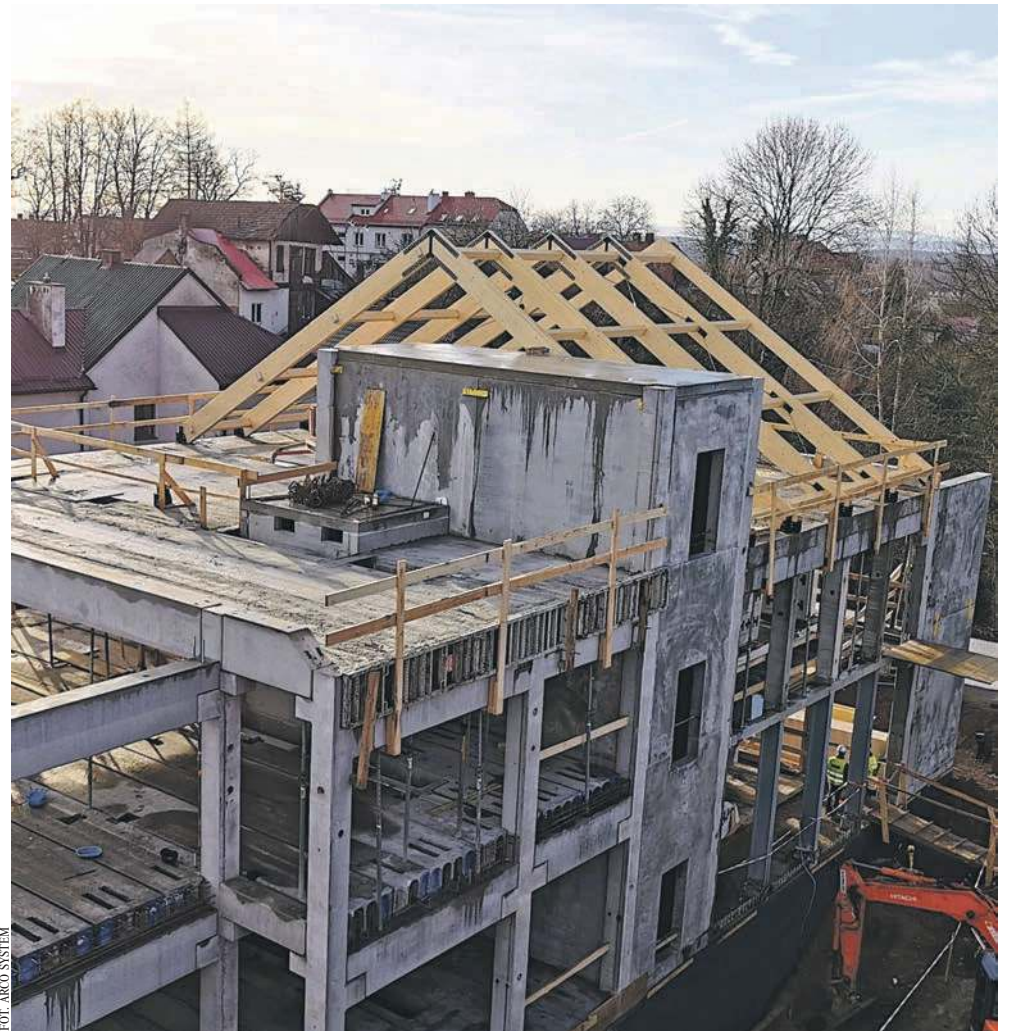
Tak obecnie wygląda budowane Muzeum Pożarnictwa przy Korycińskiego w Alwerni
