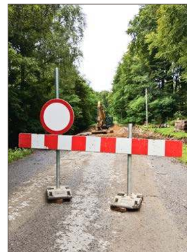
Prace potrwać do końca listopada.
