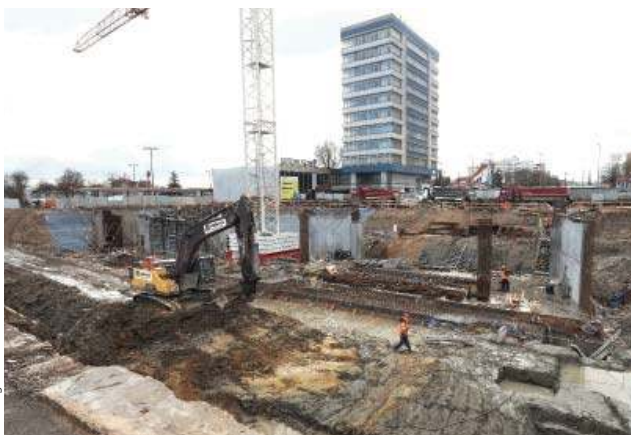
Dworzec PKP ma być oddany do użytku na początku 2024 roku
