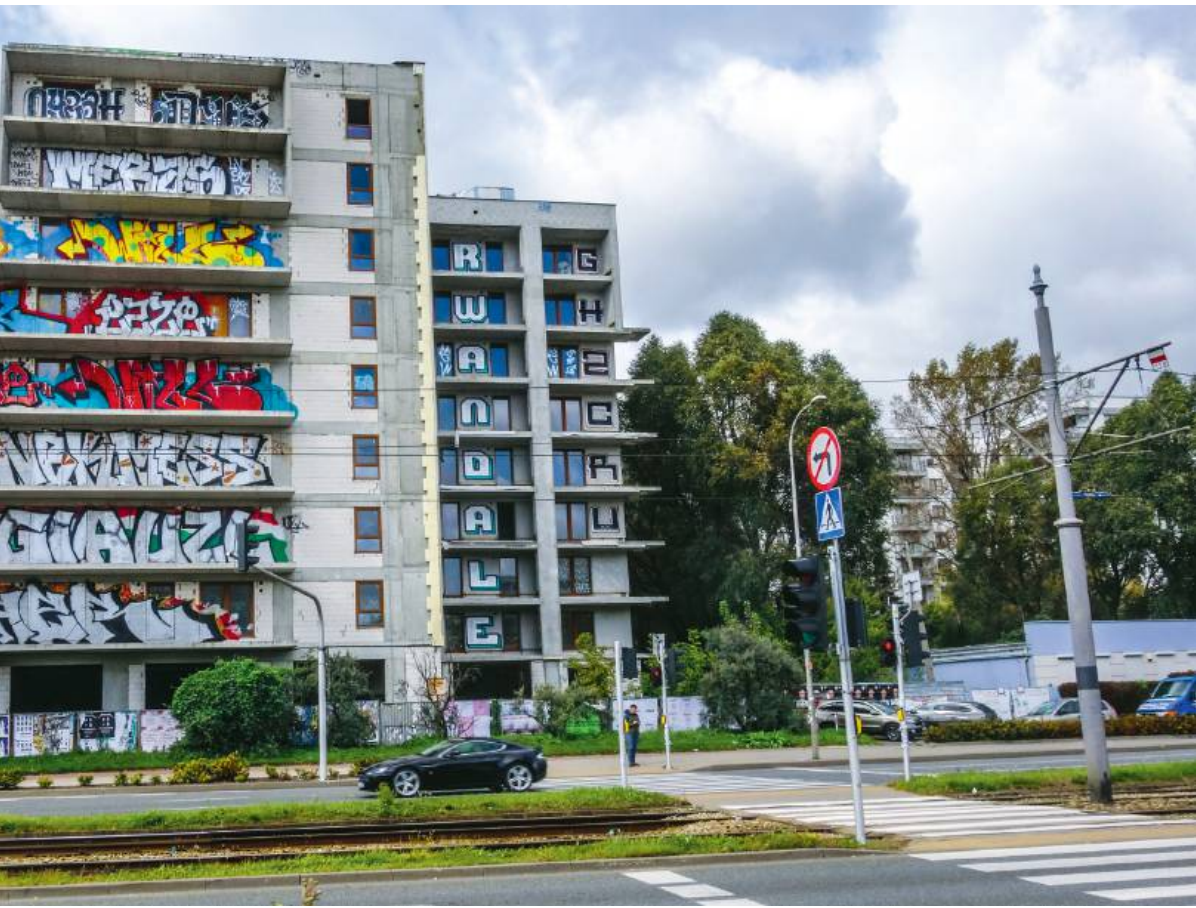
Opuszczony, liczący kilka kondygnacji blok znajduje się przy al. Krakowskiej na warszawskich Włochach | fot. Włodzimierz Wasyluk/Gazeta Polska
