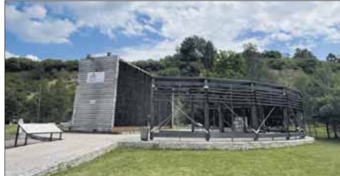
Tężnia solankowa na terenie GEOsfery
