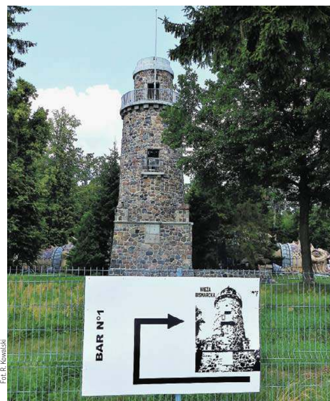
Wieża Bismarcka — stan obecny
