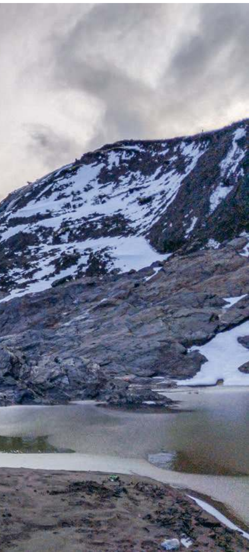
Zniszczony wał ziemny przy tamie w Stroniu Śląskim, 7 grudnia 2024 r.
