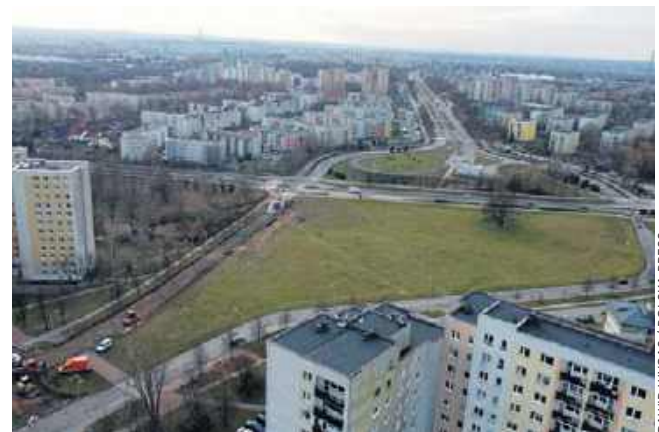
Trwa remont alei Wyzwolenia. Utrudnienia potrwają do połowy przyszłego roku
