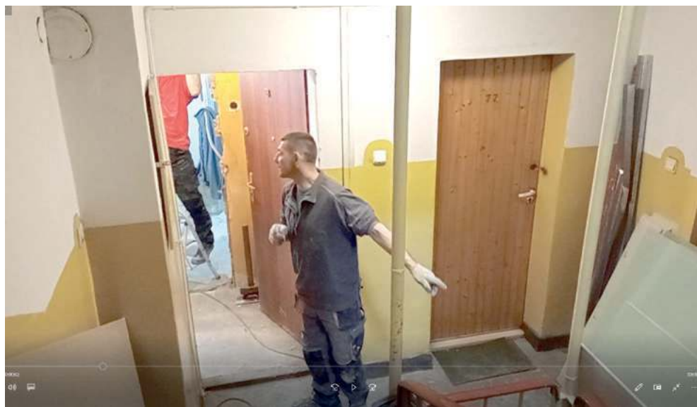
Remontowane jest mieszkanie na trzecim piętrze w bloku nr 7 na os. Chącińskiego w Łukowie
