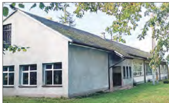
✚ Gmina planuje gruntownie przebudować opuszczony budynek szkolny i przystosować go do potrzeb sportowców (fot. Urząd Gminy Trojanów)
