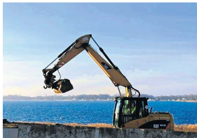
Obiekt powstaje z myślą o potrzebach szkoleniowych Państwowej Straży Pożarnej woj. podkarpackiego
