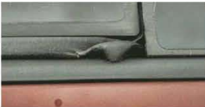
USZCZELKĘ szklanego dachu trzeba będzie wymienić. Jest nadal szczelna, ale została uszkodzona, nie wiadomo, w jaki sposób.
