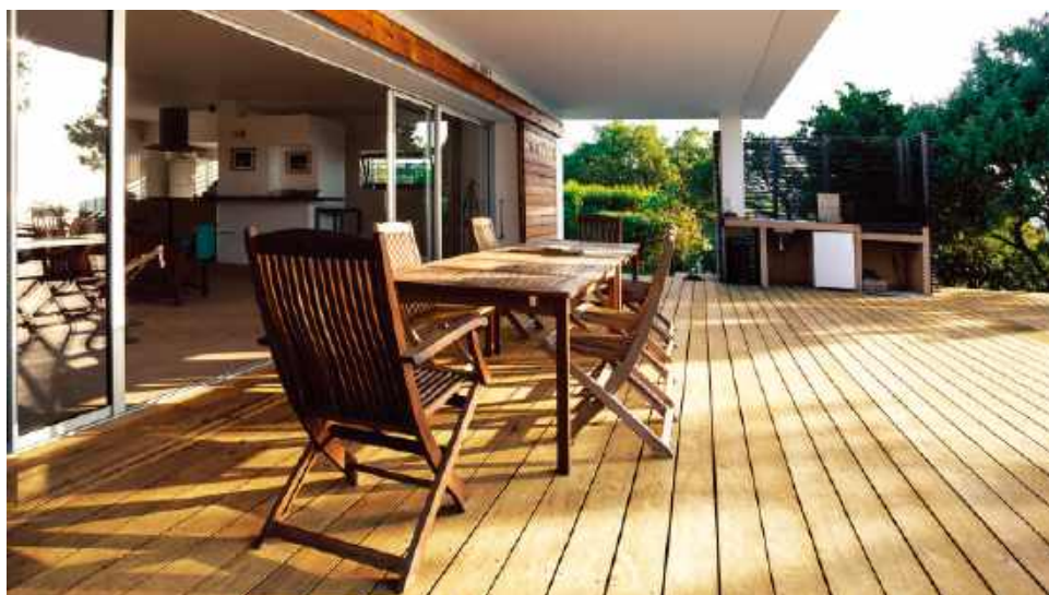
📌 Deski z drewna egzotycznego odpowiednio zabezpieczone olejem są odporne na działania wilgoci i promieniowania UV. JAF POLSKA
