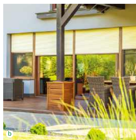
📍 Roleta natynkowa w kasce, montowana na elewacji gotowego okna, widoczna z zewnątrz (a SOMFY). Roleta podtynkowa, ukryta w ścianie nad oknem; montuje się ją na etapie wznoszenia ścian i tynku (b KRISHOME).
