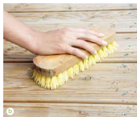
📌 Do mycia całego tarasu najlepiej użyć myjki ciśnieniowej (a KÄRCHER). Miejskowe zabrudzenia w postaci plam można usunąć szczotką ręczną (b JAF POLSKA).
