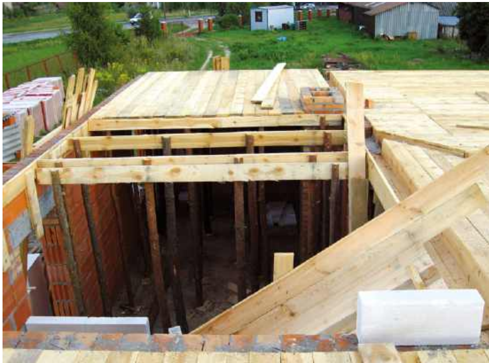
❶ Dobrą zdolność tłumienia hałasu mają stropy o dużej masie, np. monolityczne żelbetowe. M. SZYMANIK
