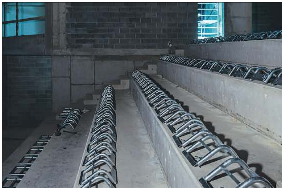
Na widowni nowej hali trwał montaż stelaży pod krzeselka
