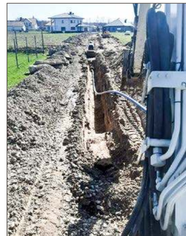
Powstanie ponad 4 km sieci kanalizacyjnej.
