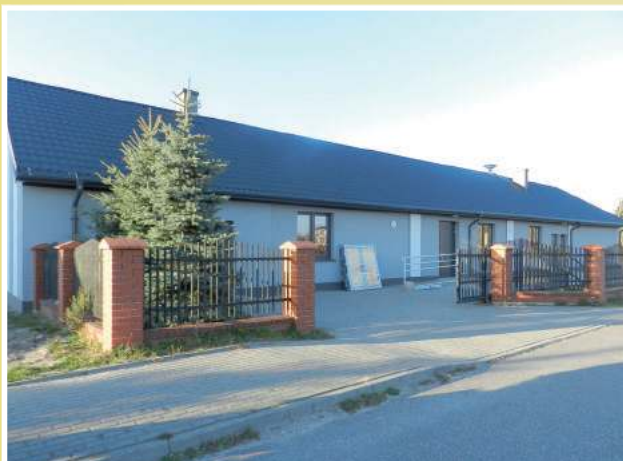
Trwają prace termomodernizacyjne świetlicy w Tłuszc. Polegają one m.in. na dociepleniu budynku, wymianie okien i drzwi, wykonany będzie też podjazd dla osób niepełnosprawnych.
