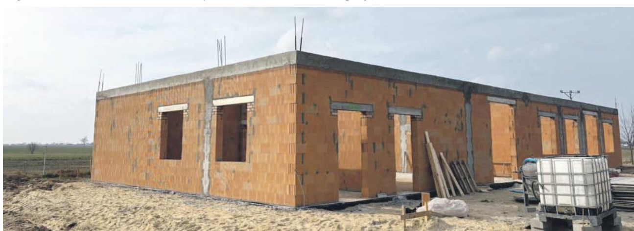
Trwa budowa świetlicy w Marszowicach
