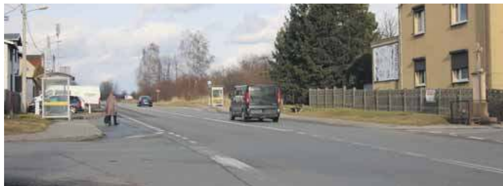
Wykonawca ma sześć miesięcy na przebudowę skrzyżowania
