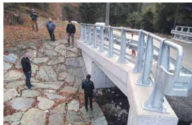
Tak wygląda nowy most na osiedlu Jaszczce.
