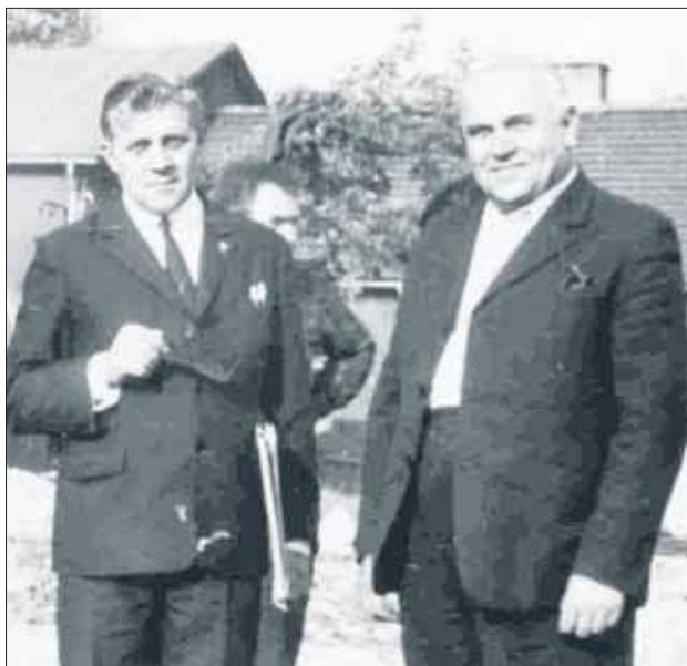
Profesor Wiktor Zin (po lewej) na placu budowy jaworznickiego kościoła (MMJ)
