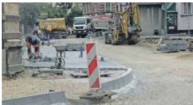
Przy ul. Powstańców Śląskich, od skrzyżowania z ul. Okrzei do skrzyżowania z ul. Świdra trwa budowa chodników
