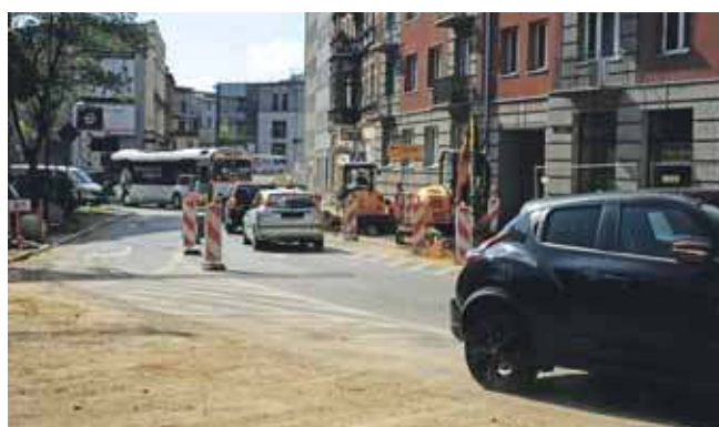
Skrzyżowanie jednak zostanie zamknięte. Wystąpił o to wykonawca, uzasadniając wniosek bezpieczeństwem kierowców
