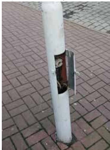
Konserwacja obejmie także naprawę lub wymianę kabli energetycznych, w których wykonawca stwierdzi brak ciągłości działania.
