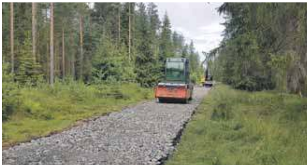
Prace nad nowymi odcinkami ścieżek rowerowych idą pełną parą. Będzie można z nich skorzystać jeszcze w tym roku.
