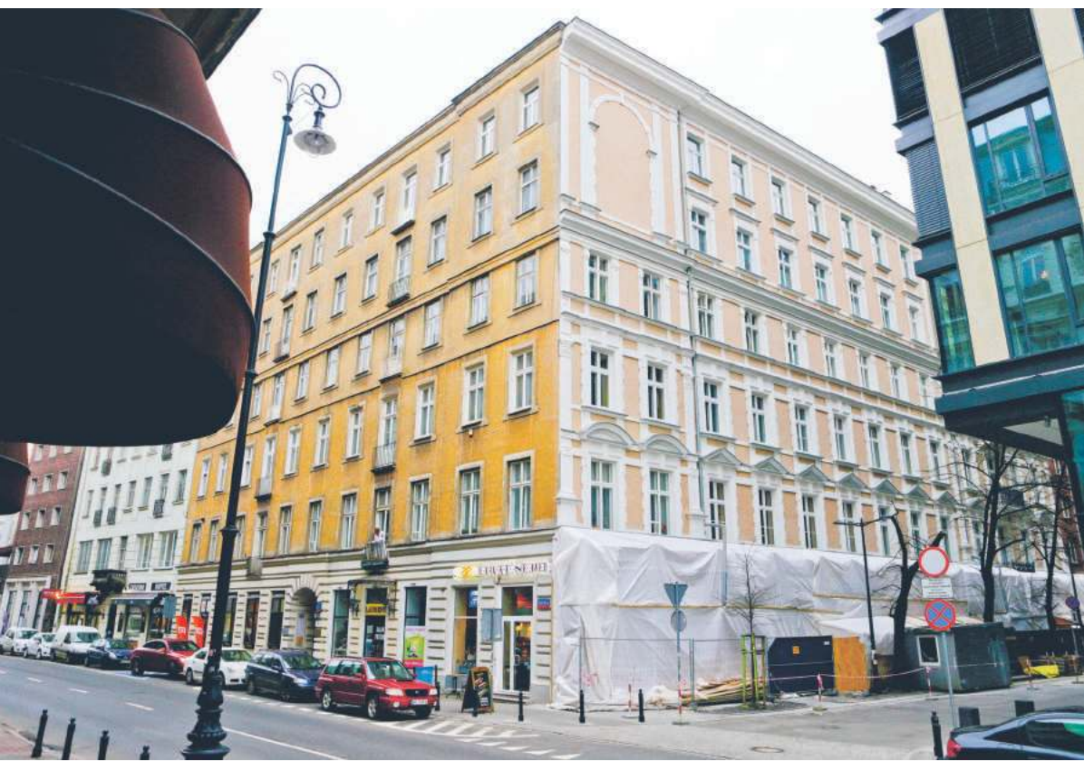
Za dwa tygodnie elewacja kamienicy od strony ul. Przeskok będzie już gotowa | fot. Tomasz Hamrat/Gazeta Polska
