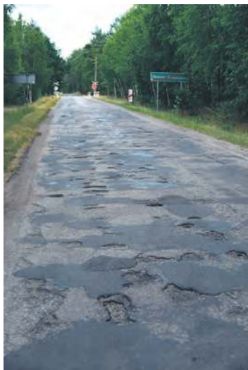
Tak wygląda odcinek w okolicy przejazdu kolejowego.
