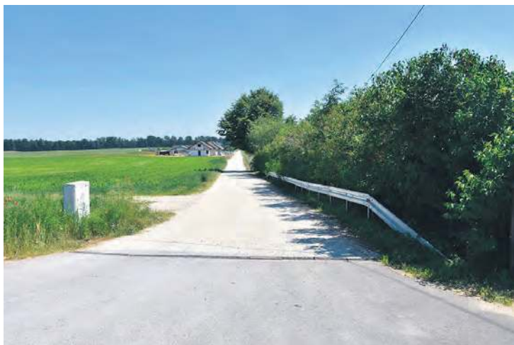
Droga w Łyskowie w kierunku Świtu zostanie wykonana w nawierzchni asfaltowej.
