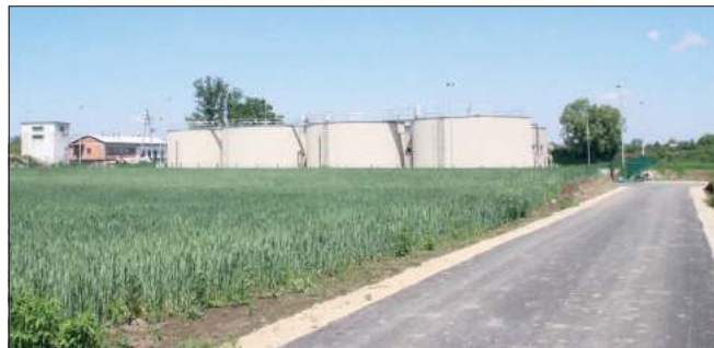
Do oczyszczalni została doprowadzona droga, choć brakuje jeszcze jej nazwy. Mają ją nadać radni.
