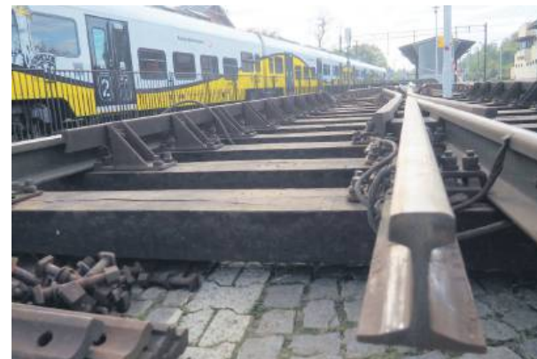
Nawierzchnia torowa musi być przystosowana do obciążeń składów i wyprofilowana zgodnie z geometrią trasy
