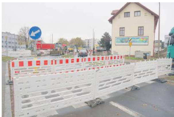
Na strzelińskim rondzie rozpoczął się tzw. trzeci etap inwestycji, a to skutkuje częściowym zamknięciem południowo-wschodniego wlotu skrzyżowania ronda od ul. Wojska Polskiego. Fot. UMiG Strzelin
