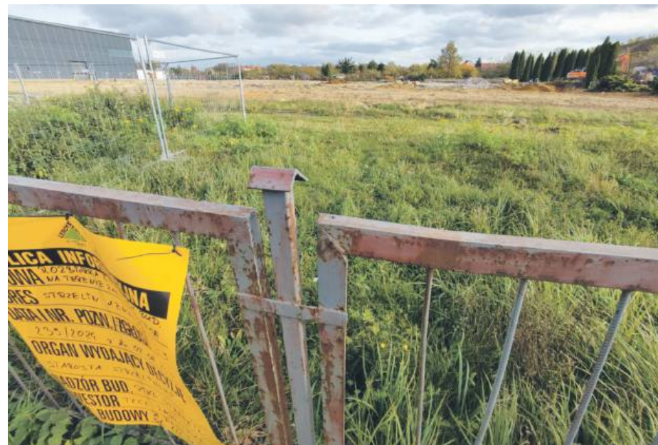
W miejscu, gdzie kiedyś stały budynki zakładu produkującego elastyczne kontenery, dziś jest tylko nierówny plac po rozbiórce. Na tabliczce jest informacja, że inwestorem jest firma TECE
