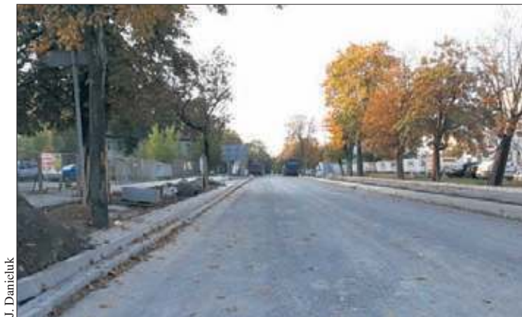
Na odcinku al. Kilińskiego pomiędzy ulicami 3 Maja i Sienkiewicza trwa już odtwarzanie jezdni, chodników oraz budowa ścieżki rowerowej
