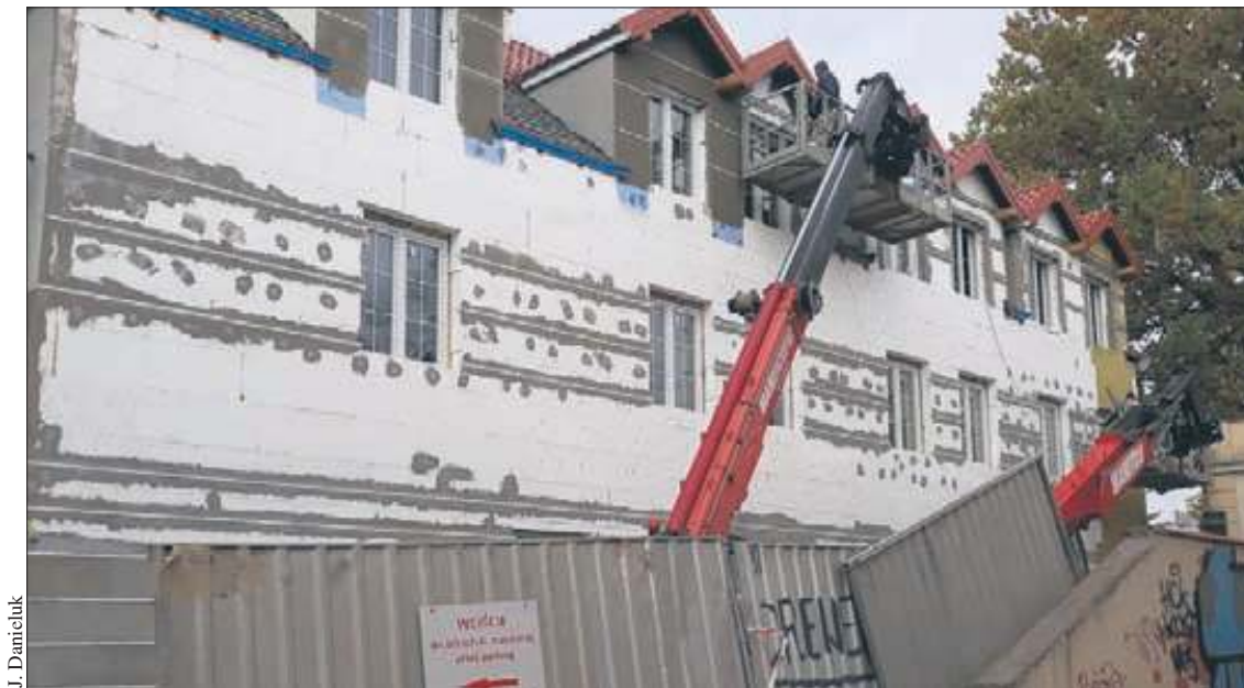
Trwa budowa nowego budynku przy ul. Kościuszki 3b
