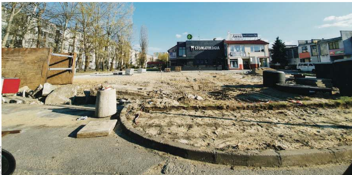
Remont parkingu przy ulicy Okulickiego powinien zakończyć się początkiem maja
