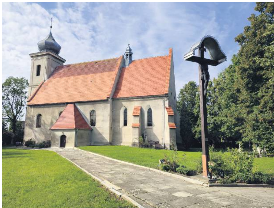
Kościół filialny pw. Św. Floriana w Starym Wiązowie wymaga nakładów finansowych na remont ścian
