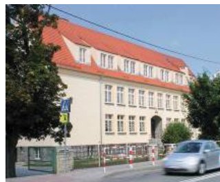
Podczas jednej z nawałnic został uszkodzony dach Szkoły Podstawowej w Wiązowie, więc radni zdecydowali o przekazaniu 15 tys. zł na jego naprawę
