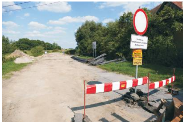
Fragment ul. Brzegowej od ul. Wojska Polskiego jest zamknięty. Trwają tam prace związane z przebudową tej drogi i remontem mostu
