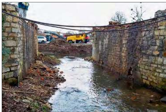
Roboty drogowe na DW409 obejmują m.in. modernizację trzech mostów.
