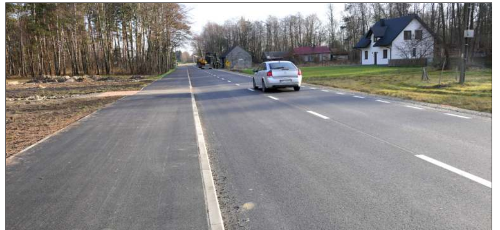
I kolejna udana inwestycja drogowa, tym razem w Kupnie, która obejmowała: poszerzenie jezdni do 6 metrów, budowę ścieżki pieszko-rowerowej o szerokości 3 metrów na prawie 3-kilometrowym odcinku, modernizację odwodnienia, wykonanie poboczy, zjazdów oraz nowego oznakowania pionowego i poziomego, które zwiększa czytelność i bezpieczeństwo ruchu.
