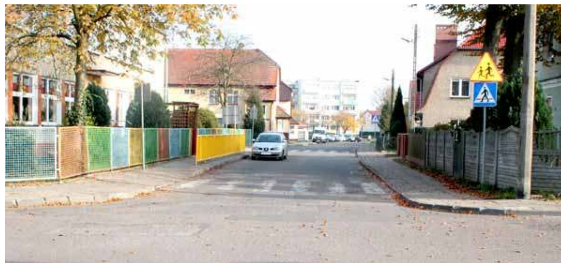
Skrzyżowanie ul. Żeromskiego z Sienkiewicza- tu ma się zakończyć II etap remontu ulicy
