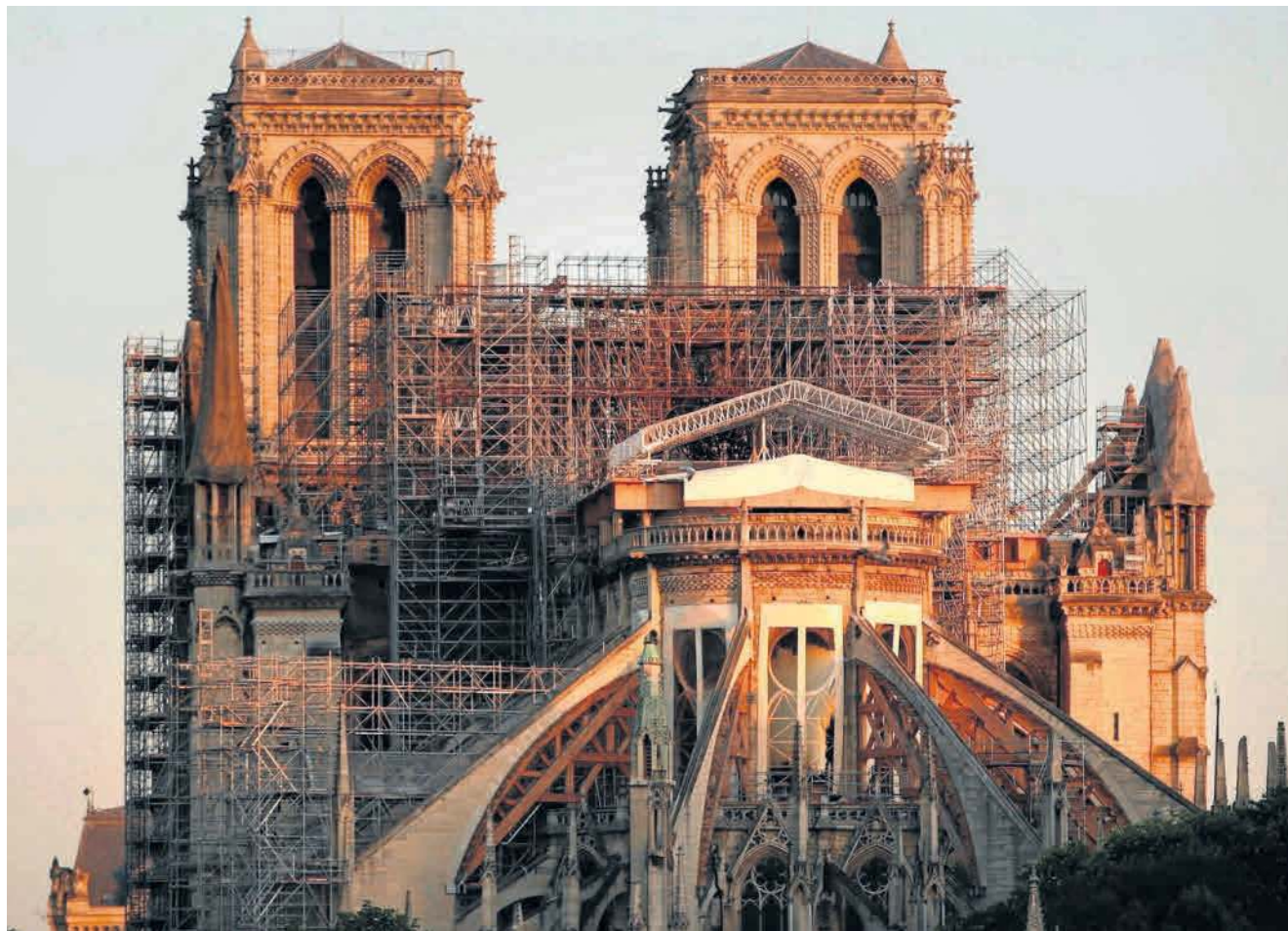
Od feralnego 15 kwietnia mijają już dwa lata, ale prace posuwają się bardzo powoli
