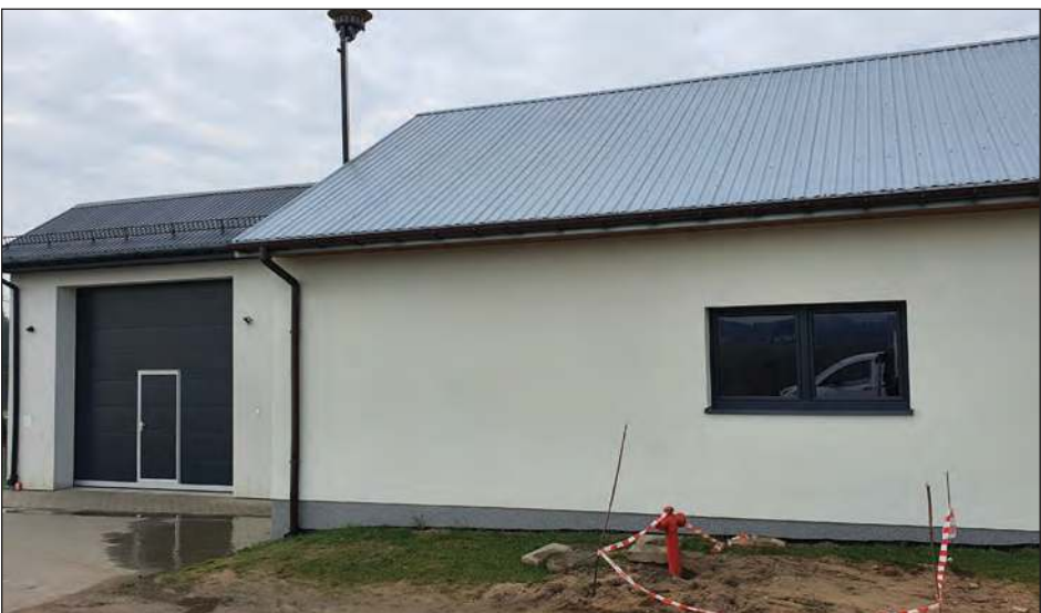
Hydrant przy strażnicy w Trzciance został naprawiony w czwartek, 28 kwietnia
