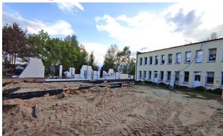
Budowa żłobka (na zdjęciu w trakcie prac) idzie jak po grudzie.
