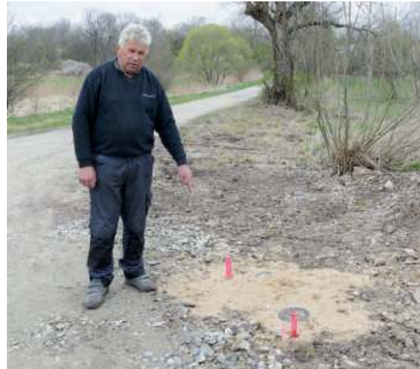
- W końcu ruszyły długo oczekiwane prace budowy wodociągu w naszej wsi – mówi Ryszard Przyszlak, sołtys Mnikowa. - To jest dla nas powód do zadowolenia, nareszcie będzie inaczej, chwała Bogu
