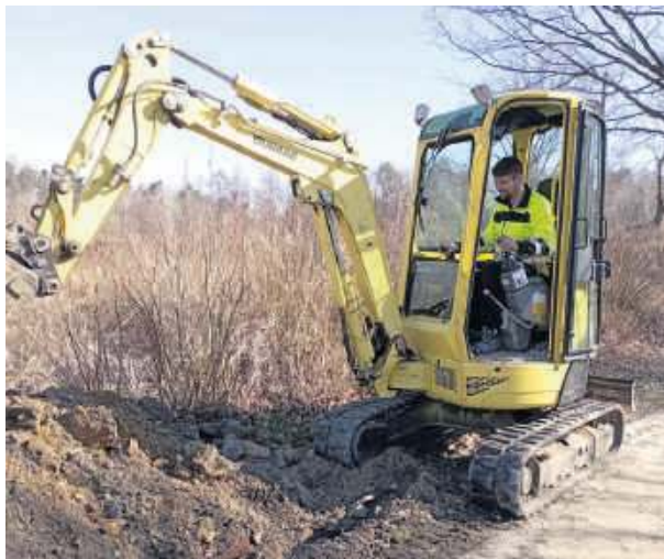
Wykonawcą zadania jest PHU Waldemar Ginter z Przeworna. Foto: UG Przeworno
