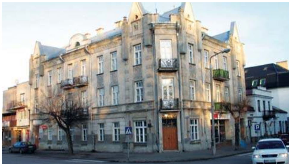
Stan obecny po byłym hotelu. Po II Wojnie Światowej był Dom Towarowy a po 1989 r. sklep
