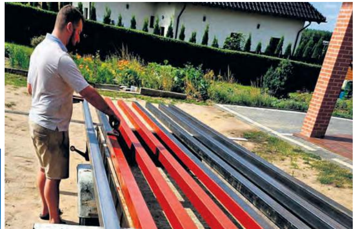
Prace związane z odświeżeniem słupów oraz przygotowaniem lamp solarnych do montażu radny Karol Sikorski wykonał samodzielnie.
