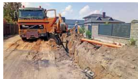
Budowa sieci kana- lizacyjnej Osiedle Śniegockiego
