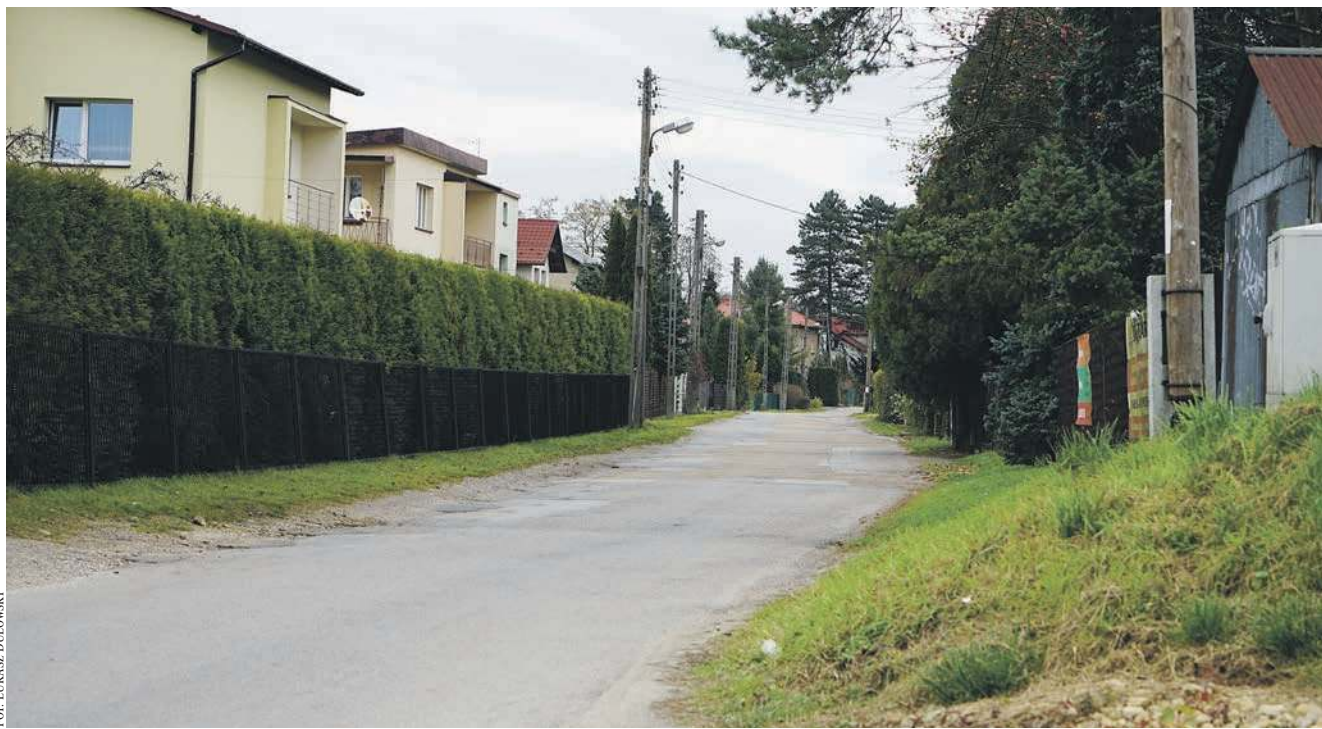
Najpierw należałoby zmodernizować wąską ul. Mydlaną w Chrzanowie, a potem wprowadzać tutaj większy ruch samochodowy
