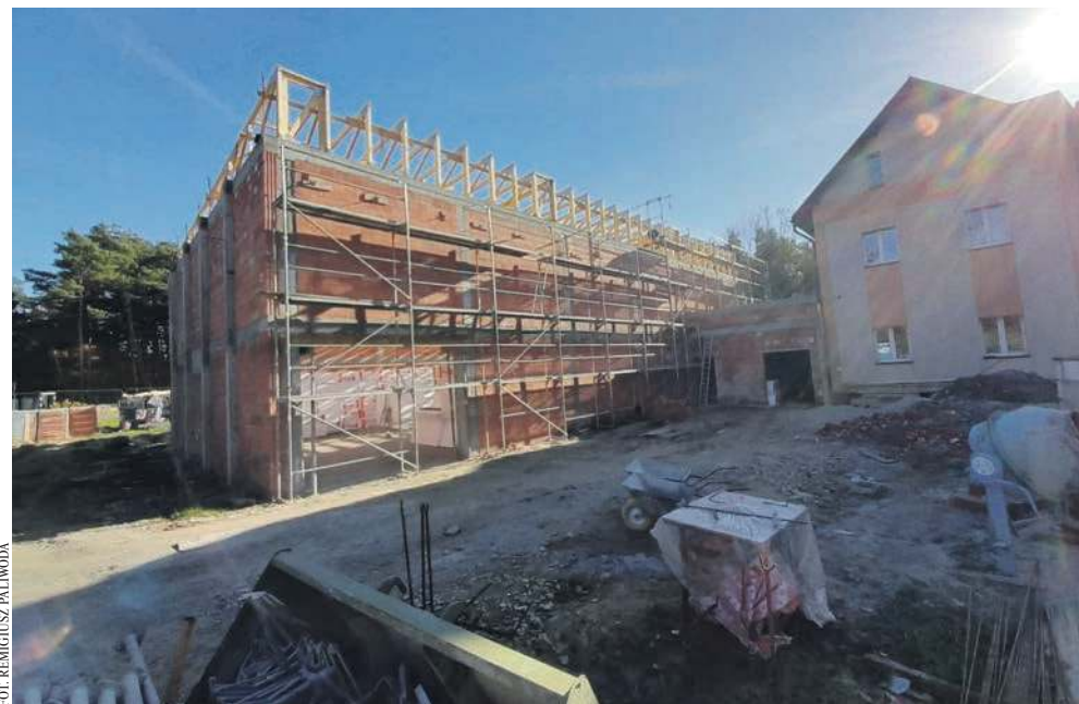
Trwa budowa sali gimnastycznej w Jankowicach
