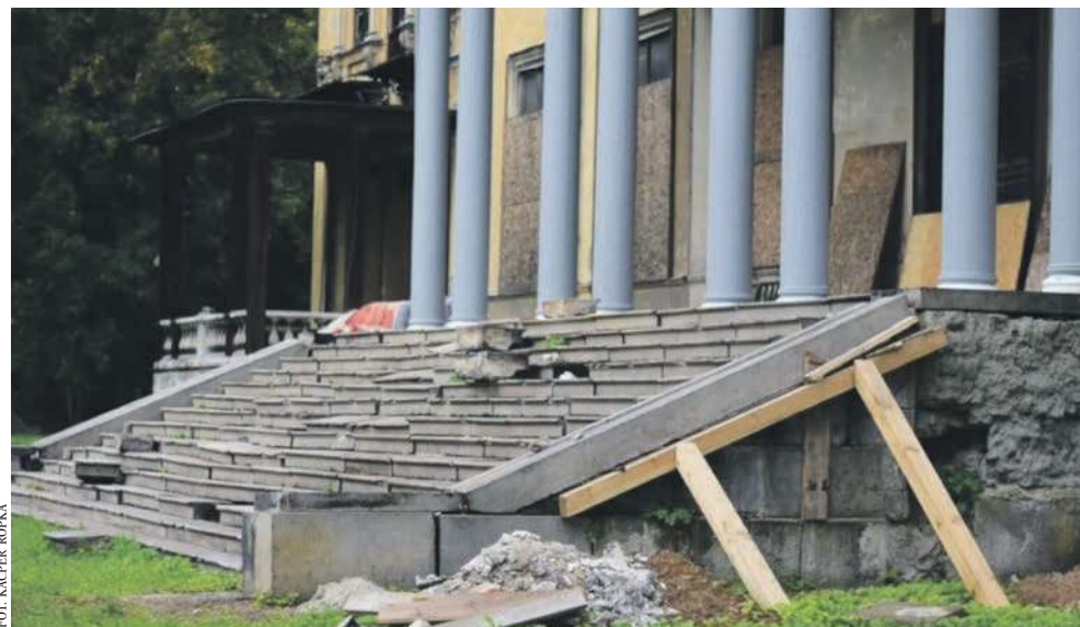
W pałacu Potockich w Krzeszowicach prowadzone są prace zabezpieczające
