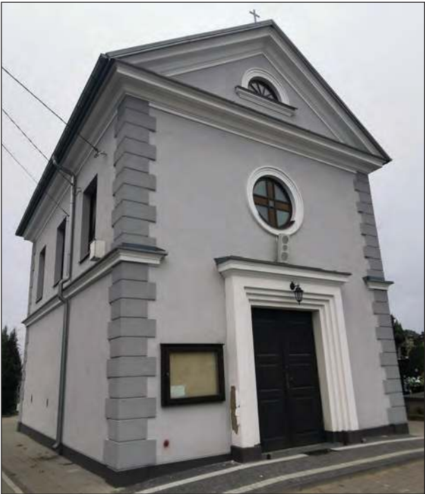
✚ Środki z cmentarnych opłat pozwoliły na remont kaplicy św. Antoniego. Ks. Szymuś informuje, że aby ograniczyć koszty, prace remontowe wykonywali pracownicy cmentarza
