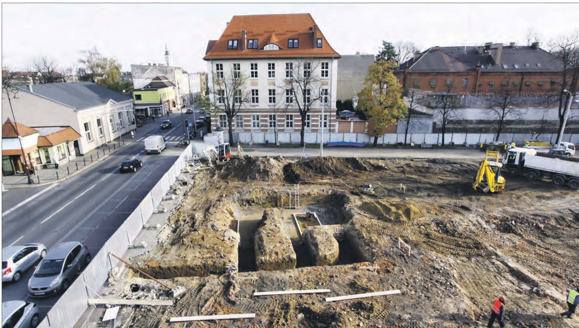
Odsłonięty fragment fundamentów i piwnic Domu Katolickiego Związku Czeladników
