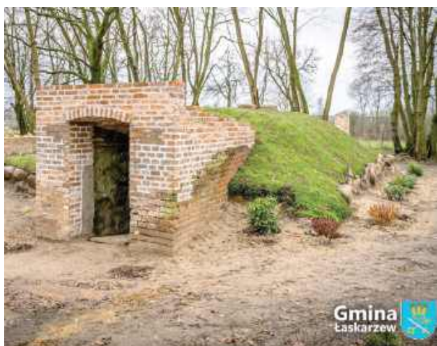
Przeprowadzono remont starej ziemianki
