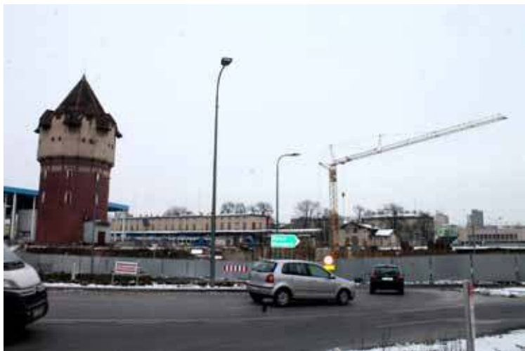
Kierowcy, ale również przechodnie, z niecierpliwością czekają na ponowne oddanie do użytku wiaduktu na Wyszyńskiego, łączącego część miasta wzdłuż ul. Szczecińskiej z centrum
